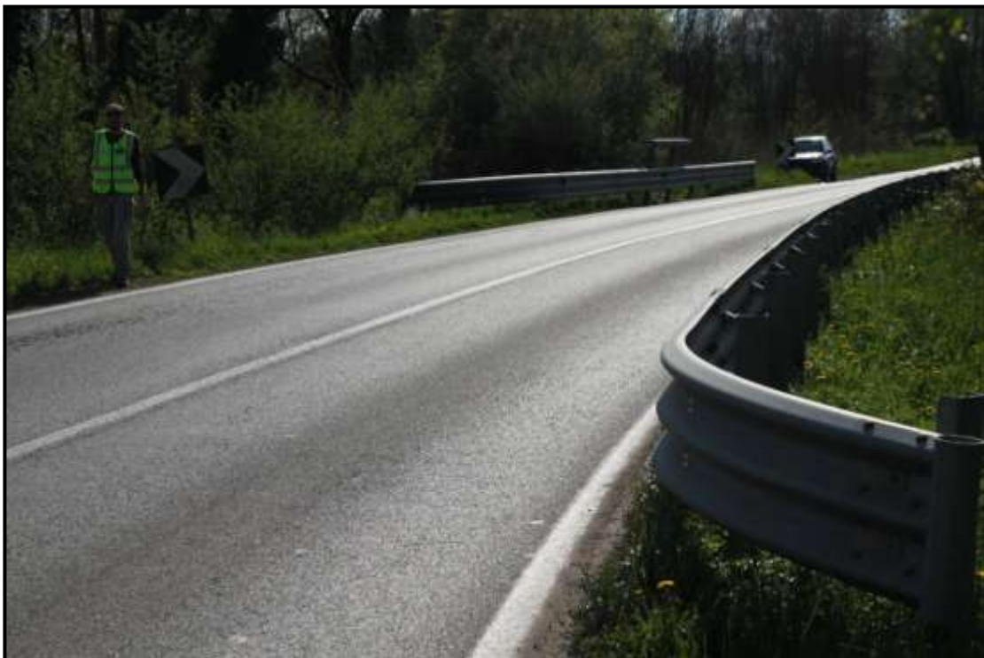
Sito di intervento C10e sulla SP 36 tra il lago di Varese e la palude Brabbia
