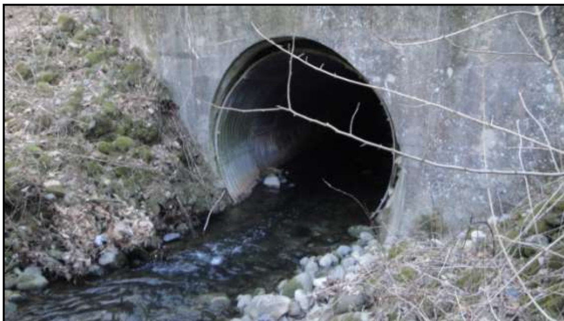
Passaggio del torrente Acqua Nera sotto la SS 629 privo di strutture idonee al passaggio di piccola e media fauna
