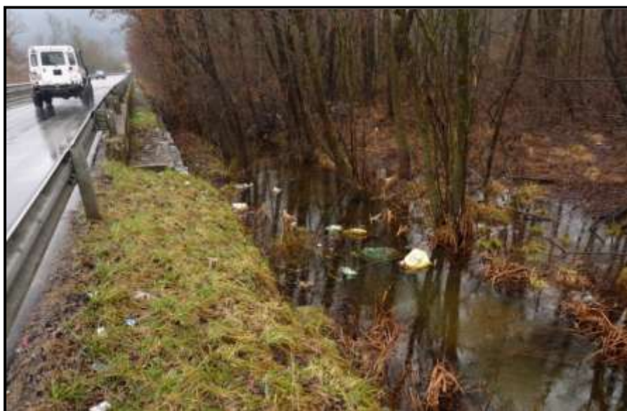
Situazione di degrado ambientale evidente lungo i bordi della SP 53 nel sito di monitoraggio C11c
