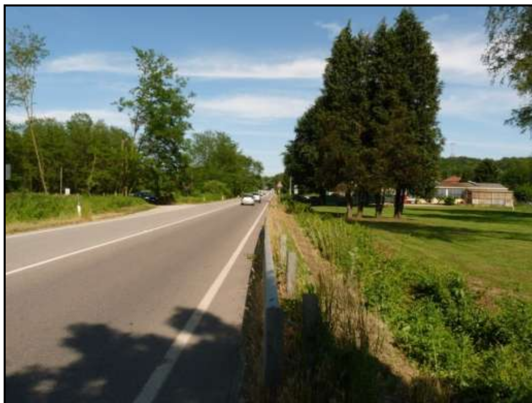
Il tratto della SS 33 scelto per l'intervento C10a
